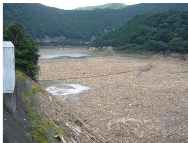
図-1 ダム流木(椿山ダム, 2011年9月撮影)
